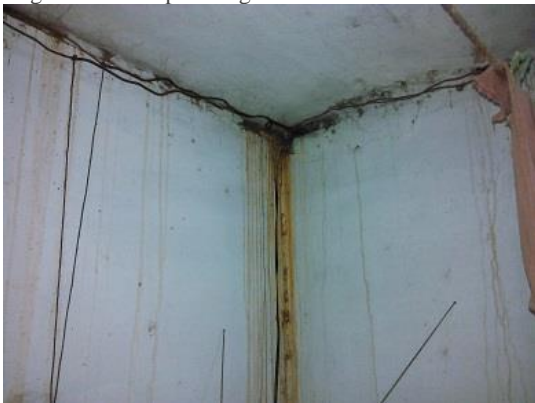
Filtraciones en las paredes.
