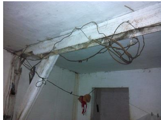
Electricidad en mal estado.
