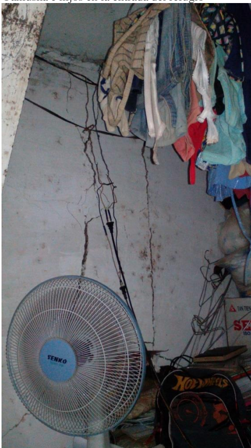
Paredes grietadas del refugio.
